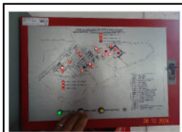
ทำการเปลี่ยนหลอดไฟแสดงโซน 8 ที่ชำรุดเรียบร้อยแล้ว
