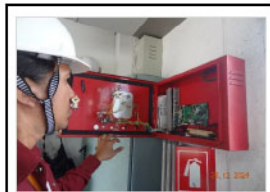
ทำการเปลี่ยนหลอดไฟแสดงโซน 8 ที่ชำรุด
